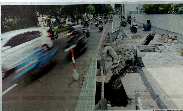
PERBAIKAN SAH: Pengendara motor melintas di samping pengerjaan saluran air hujan (SAH) di Jalan Suroto, Kotabaru, Gondokusuman, Jogja, Rabu (8/12). Pengerjaan dilakukan DPUPKP Kota Jogja untuk mengantisipasi banjir di beberapa titik rawan kawasan Kota Jogja.
