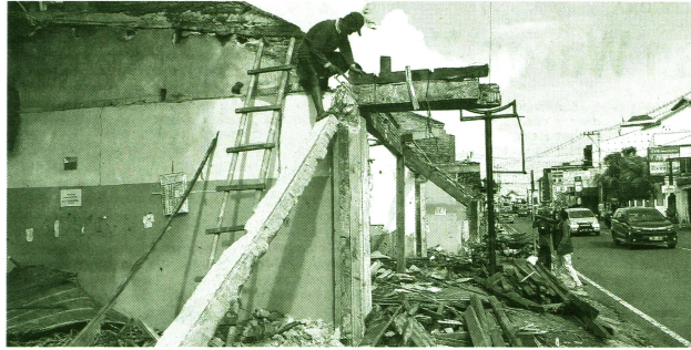
Pekerja membongkar bangunan kios yang terdapat di Jalan Pasar Kembang belum lama ini. PT KAI Daop 6 berencana membangun area parkir dan kawasan pedestrian di lokasi itu sebagai bagian dari penataan kawasan sumbu filosofi.
