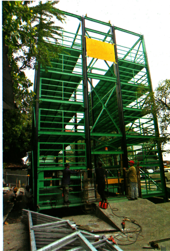
FINISHING: Pekerja menyelesaikan pembangunan parkir vertikal di kompleks Balai Kota Timoho, Kota Jogja, Senin (6/12). Pemkot Jogja menargetkan operasional parkir vertikal itu bisa dimulai pada awal tahun depan.
