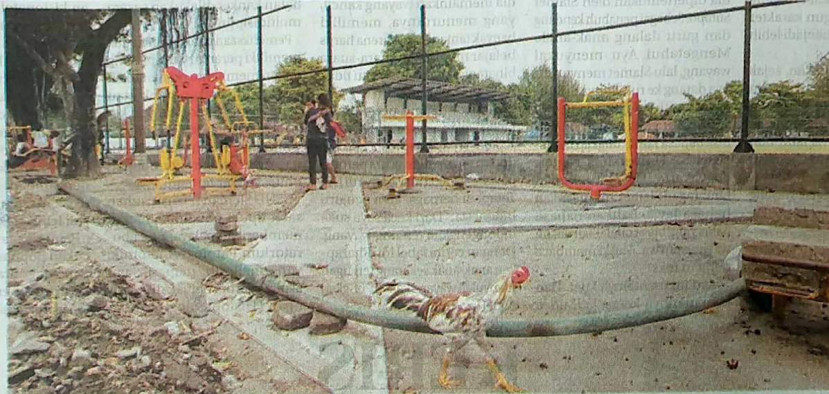
STANDAR NASIONAL: Pembangunan Lapangan Karang, Prenggan, Kotagede, menjadi stadion mini berstandar nasional, kemarin (7/11). Pembangunan tersebut ditarget selesai pada akhir tahun ini dan menelan biaya sekitar Rp 7,3 miliar dari APBD Kota Jogja.
