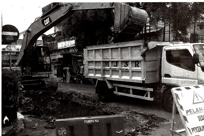
Suasana pengerjaan revitalisasi sirip Malioboro di Jalan Perwakilan, Selasa (19/10). DPUPKP Kota Jogja menargetkan pembangunan selesai pada Desember 2020.
