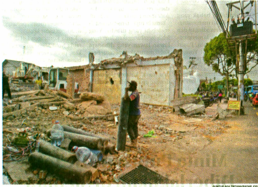
BONGKAR: Pekerja membongkar sebuah bangunan sebagai bagian dari proyek lanjutan revitalisasi Jokteng Lor Wetan, Gondomanan, Jogja, kemarin (13/10).
