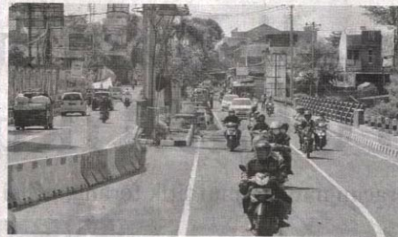
Sejumlah pengendara melintas di atas jembatan baru Kusumanegara.
