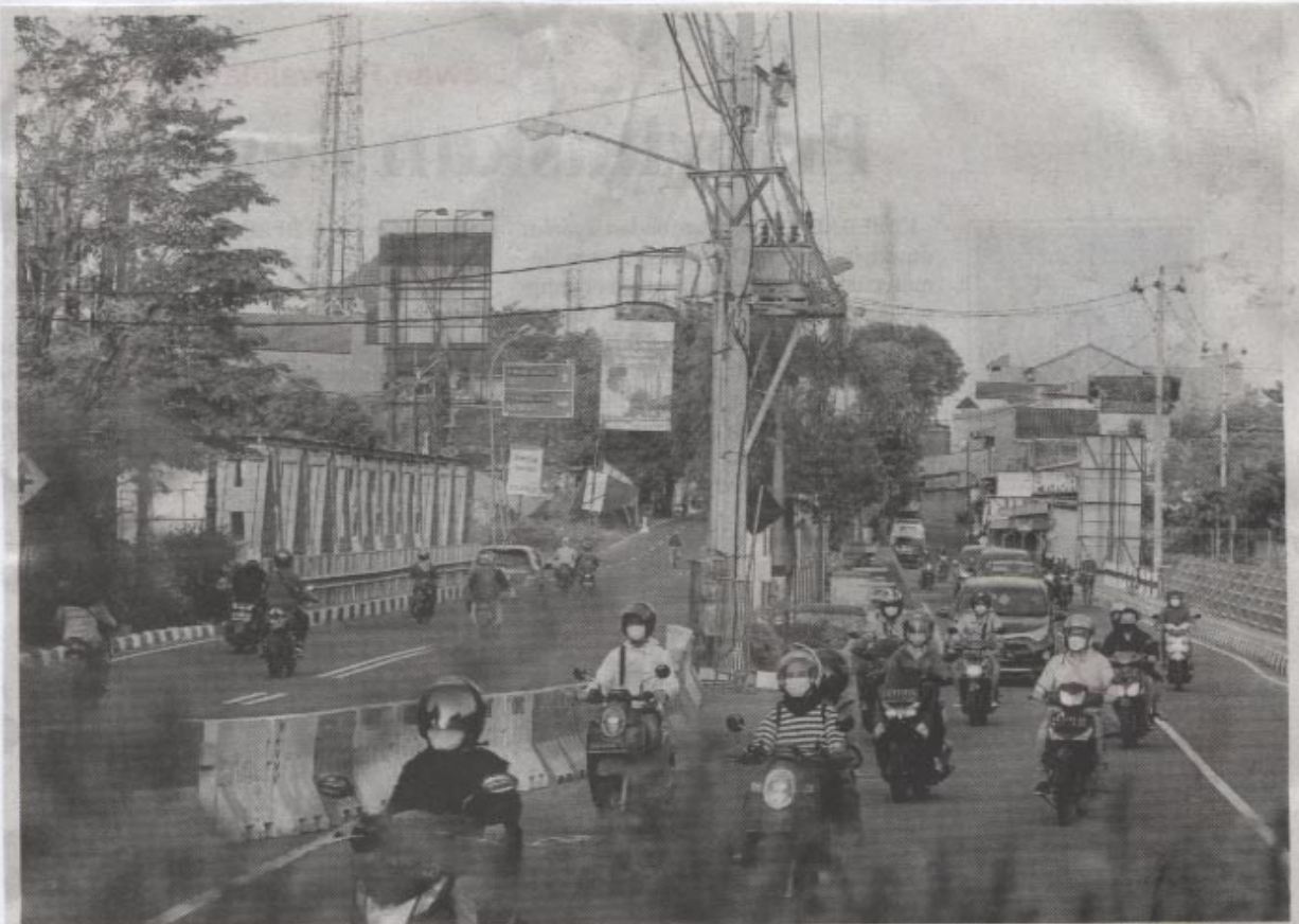
SUDAH BISA DILEWATI: Pengguna jalan melintas di jembatan baru Muja Muju yang baru dioperasikan, di Jalan Kusumanegara, Jogja, kemarin (29/4). Pengguna jalan dari arah timur melewati jembatan baru, sedangkan yang dari arah barat ke timur tetap melintasi jembatan lama.
