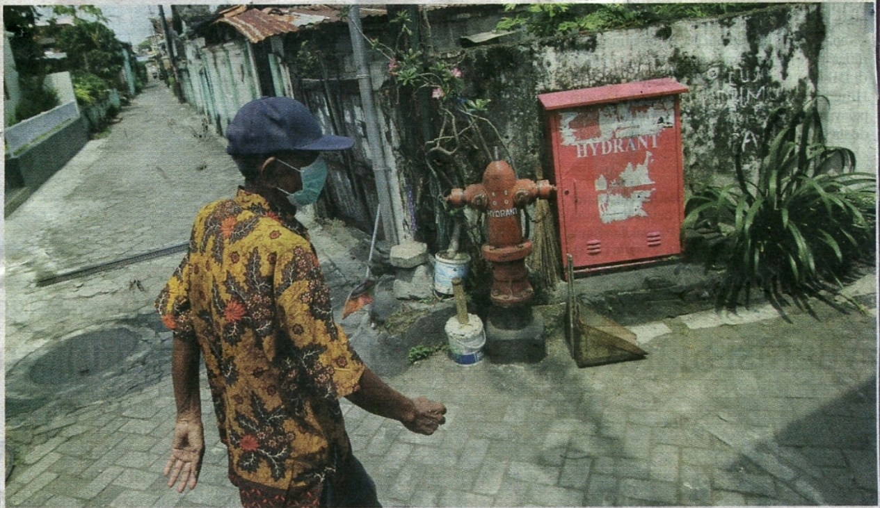
ELANG KHARISMA DEWANGGA/RADAR JOGJA ATASI KEBAKARAN: Seorang warga melintasi instalasi hydrant di kawasan Kampung Kadipaten, Kraton, Rabu (17/3). Pengadaan hidran kampung untuk mengantisipasi risiko kebakaran di kawasan padat penduduk di Kota Jogja.
