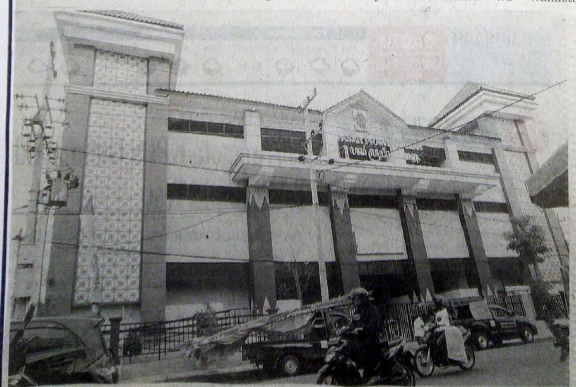
Bangunan Pasar Prawirotaman setelah direvitalisasi tampil megah.
