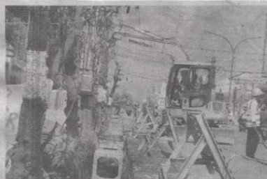
MEKAPU: TRI DARMAYATI Pekerjaan pembuatan saluran di kawasan simpang Tugu hingga Jalan Jenderal Sudirman sisi barat.
