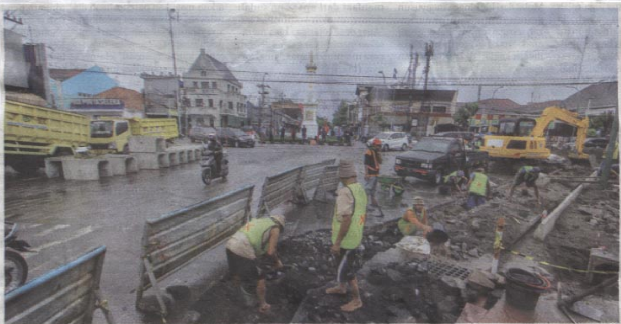
DIGALI: Para pekerja melakukan pengerjaan proyek revitalisasi kawasan Tugu dan Jalan Sudirman, Jogja, Selasa (6/10). Dishub mengimbau masyarakat untuk menghindari arus menuju Tugu sementara waktu. Sesuai rencana proyek tersebut selesai sebelum Tahun Baru 2021.
