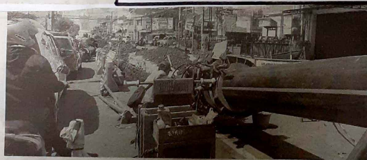
Pekerjaan saluran ducting di simpang Tugu Yogyakarta untuk memindahkan kabel listrik dan fiber optik di udara ke bawah tanah.
