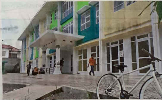
Rusunawa Bener Tegalrejo yang akan difungsikan sebagai shelter bagi pasien OTG.
