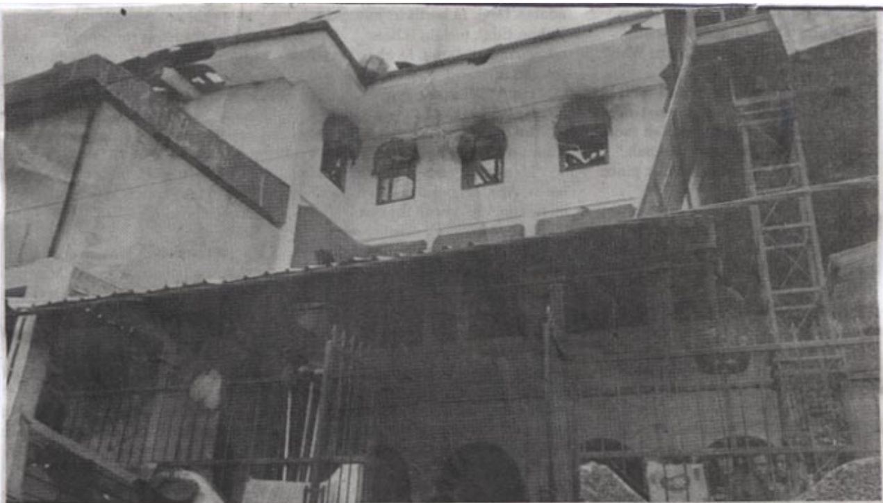
Kondisi restoran Raminten sesaat usai kebakaran.
