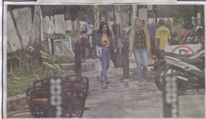
YUBANFOTO MEDIA/BERHARAJOGJA PEDESTRIAN BARU: Pejalan kaki melintas di proyek penataan kawasan pedestrian Jalan Sudirman yang tengah diselesaikan oleh pekerja, belum lama ini.
