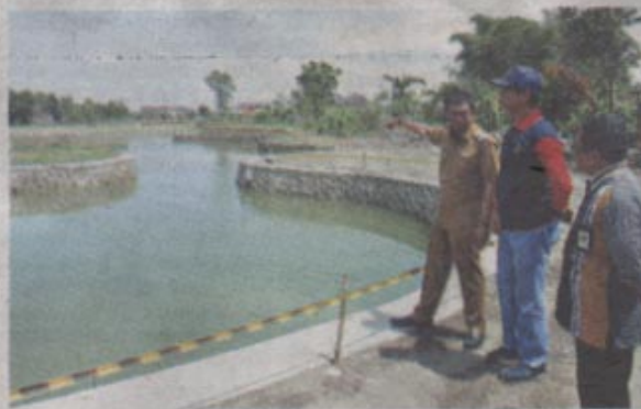
Walikota Yogya Haryadi Suyuti meninjau pembangunan Embung Giwangan.
