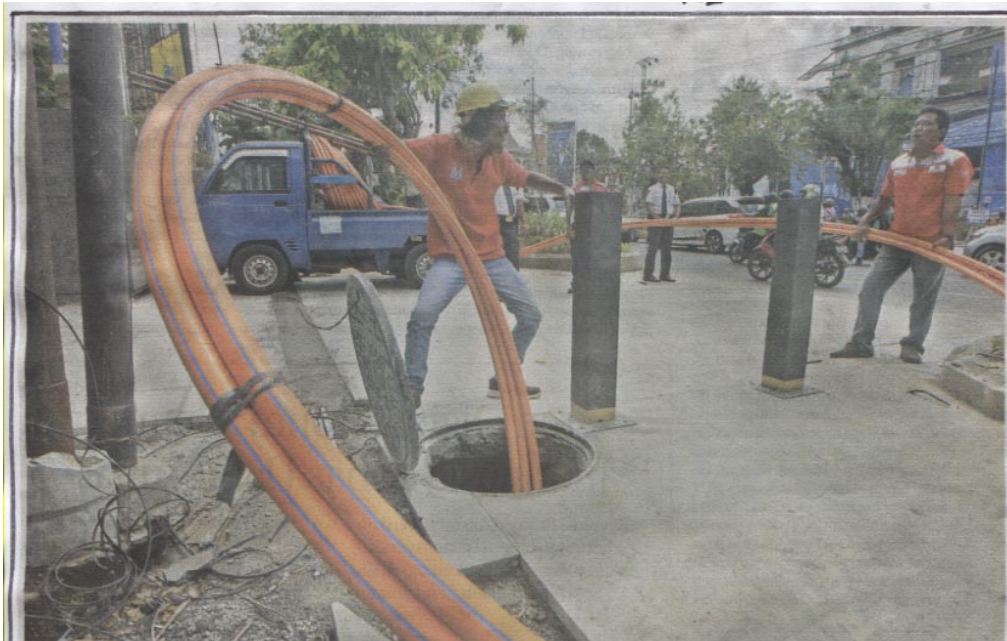
LEBIH RAPI: Pekerja memasukkan pembungkus kabel fiber optik (FO) menuju saluran bawah tanah di kawasan pedestrian Jalan Sudirman, Jogja, kemarin (9/12).
