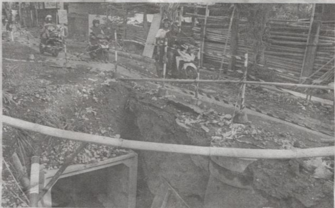
Pengendara motor melintas di lokasi proyek saluran air hujan di Jalan Babaran, Umbulharjo, Jogja, Jumat (1/11). Belum jelasnya kelanjutan pengerjaan proyek membuat warga kian waswas, terlebih hujan kini mulai mengguyur di sejumlah wilayah Kota Jogja.
