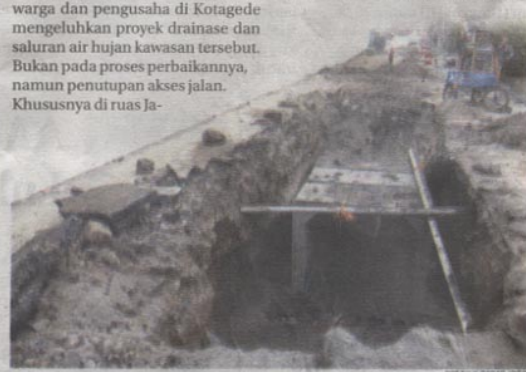
TANAM BETON: Proyek drainase saluran air hujan yang berada di tepat di sepanjang Jalan Mondorakan, Kotagede.
