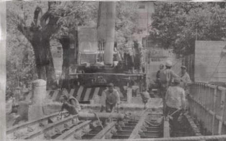
Para pekerja sedang membongkar konstruksi baja pada jembatan lama di Jalan Kusumanegara di utara Gembira Loka.
