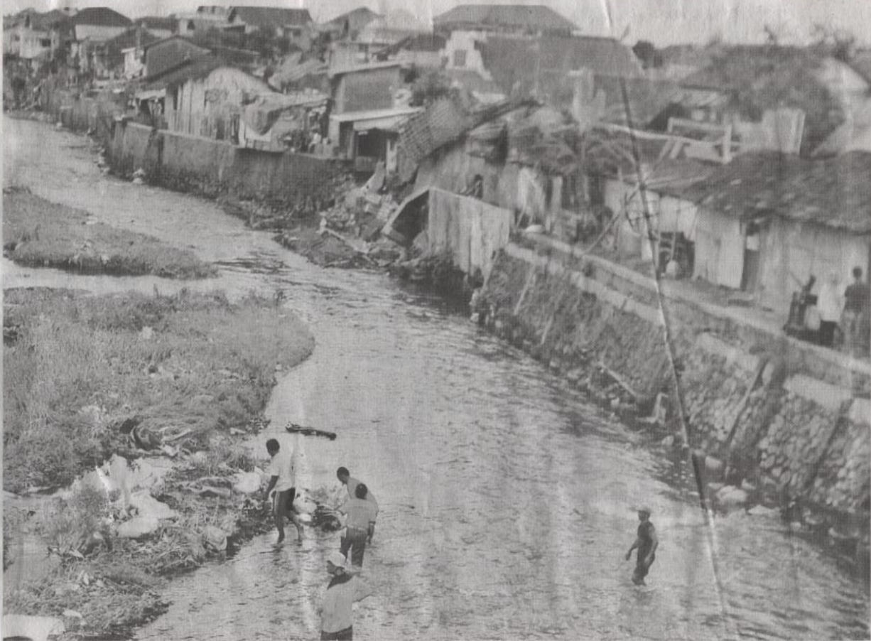
TANGGUL ROBOH : Warga mengamati balai warga yang roboh akibat tanggul penahan sungai Code yang tidak kuat menahan deras dan volume air yang meningkat paska hujan deras yang terjadi pada Selasa malam, di Prawirodirjan, Gondomanan, Yogyakarta, Rabu (5/12). (66)
