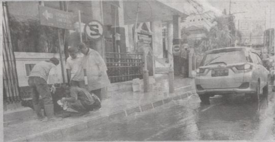
BERSIHKAN DRAINASE : Petugas dan warga mengecek saluran drainase di Jalan Suroto Kotabaru. Beberapa ruas jalan di Kota Jogja belum bebas dari genangan air saat musim hujan.
