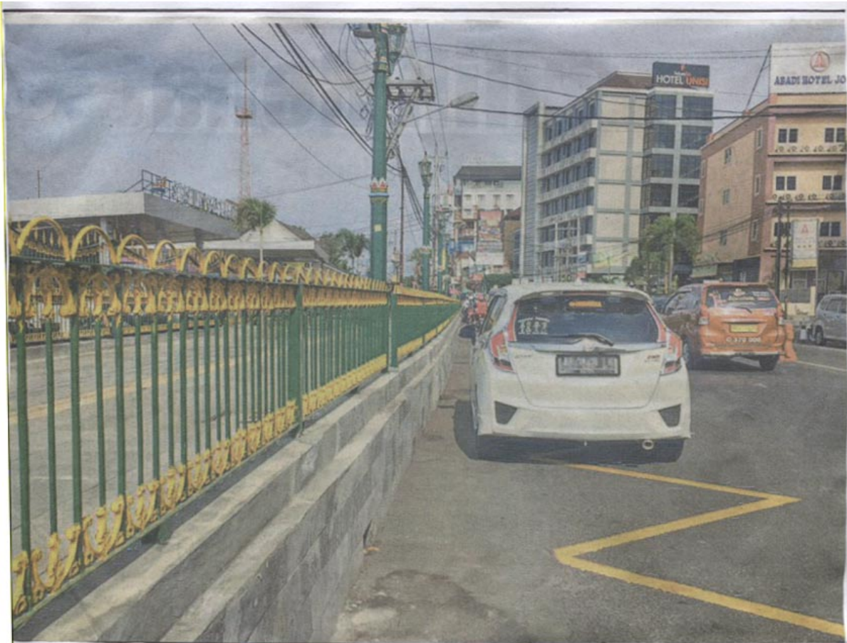
TRIBUN JOGJA/CHRISTI MAHATMA GARIS BIKU-BIKU - Dishub Kota Yogyakarta memasang garis biku-biku di Jalan Sarkem agar pengendara tak berhenti bahkan parkir di ruas jalan itu. Dipotret, Minggu (21/10).
