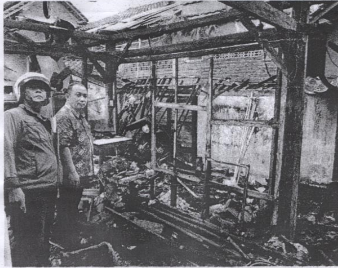
Rumah yang dihuni 3 kepala keluarga terbakar usai dipakai menggelar hajatan.
