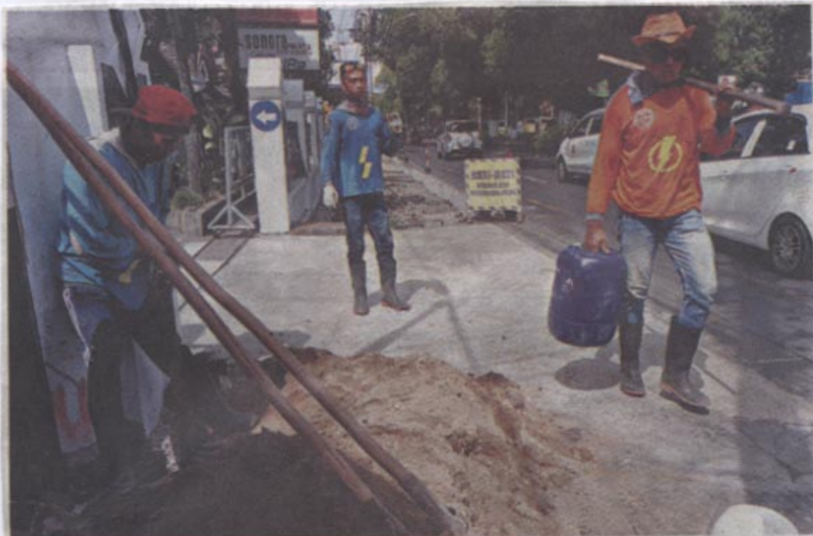
Salah satu ruas trotoar Jalan Suroto Kotabaru yang dibenahi, Sabtu (4/8).
