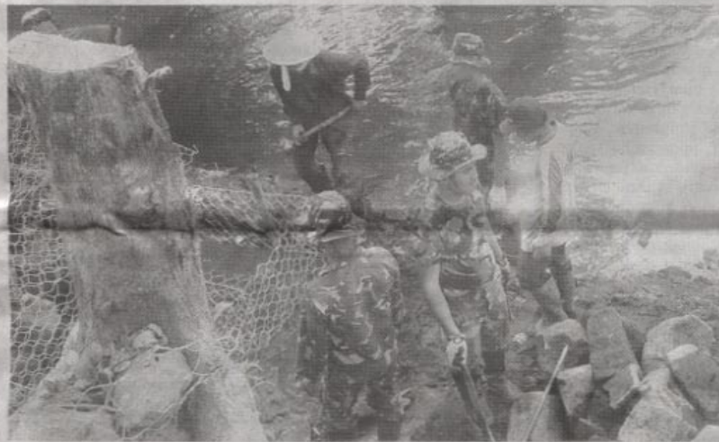
Prajurit Satgas TMMD Kodim Yogya bangun talud.
