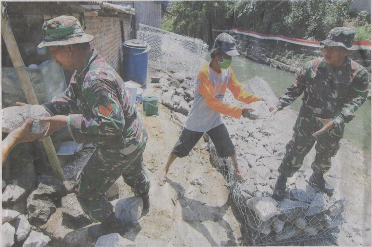
TIMBUKUNJOGLIA/BRAMASTO ADHY TMMD 2018 - TMMD ke-101 Kodim 0734/Yogyakarta resmi dijalankan satu di antaranya pembangunan talut di Pandean, Umbulharjo, Yogyakarta resmi dibuka, Rabu (4/4). Selain pembangunan talut di aliran Sungai Gajahwong, TMMD juga akan merehab rumah warga tidak layak huni (RTLH) berjumlah 10 titik, balai RW dan pembuatan MCK.
