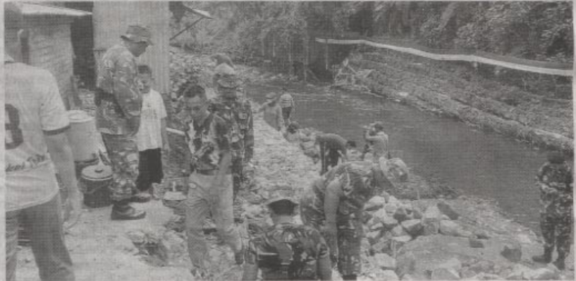
Dandim Yogya terjun dampingi prajurit bangun talud.
