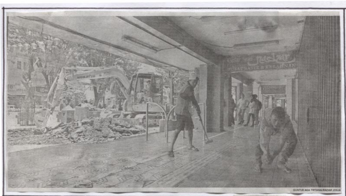
TAHAP TIGA: Seorang pekerja mengoperasikan alat berat untuk membongkar aspal jalur lambat dan dua pekerja lainnya membongkar trotoar kawasan Malioboro sisi barat, Jogjakarta, Senin, kemarin (12/3). Pengerjaan tersebut merupakan bagian dari revitalisasi Malioboro tahap ketiga dengan anggaran sebesar Rp 37,3 miliar.
