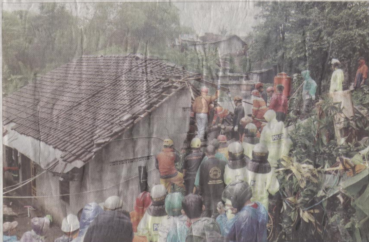
KORBAN LONGSOR: Tim SAR DIJ dibantu aparat kepolisian dan relawan bencana saat mengevakuasi rumah Subardjono di Jlagran, Pringgokusuman, Gedongtengen, Kota Jogja kemarin (28/11). Sampai tadi malam keberadaan Subardjono belum diketahui. SAHANA/RADAR JOGJA
