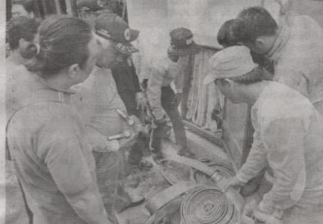
Dinas Damkar dan warga melakukan uji coba instalasi hidran kampung di Kampung Pathuk, Ngampilan.
