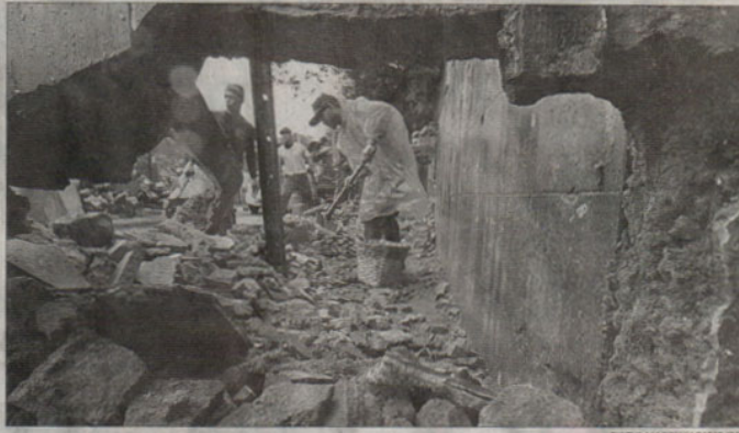
BONGKAR: Keberadaan TPS di Jalan Suryonegaran dibongkar karena dinilai menghambat lalu lintas jika ada truk pengangkut yang sedang mengambil sampah.
