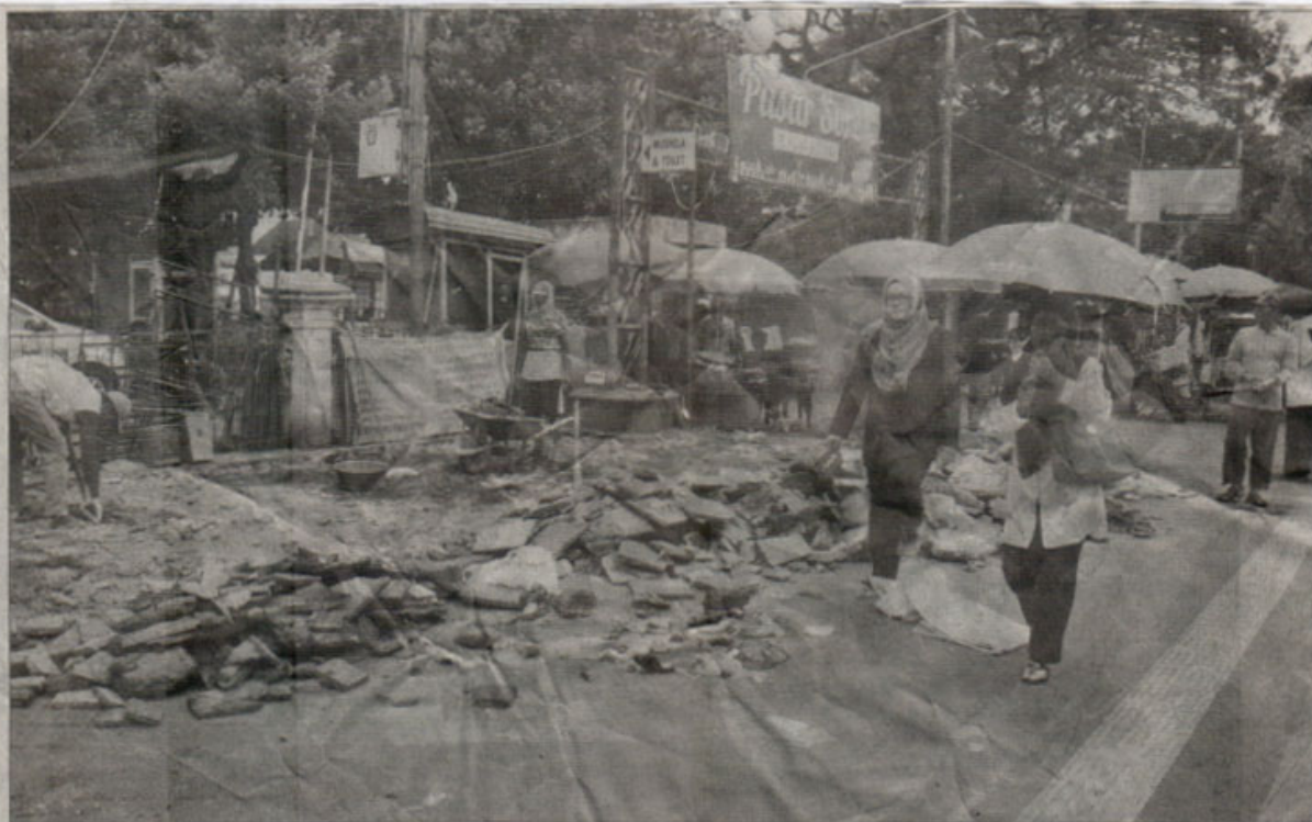
DIBONGKAR DULU: Lantai di sepanjang depan Pasar Sore kini dibongkar. Nantinya akan dilakukan pengecoran, menyusul dimulainya revitalisasi tahap dua semi pedestrian Malioboro . PKL sendiri mendukung karena sudah ada komitmen sebelumnya.
