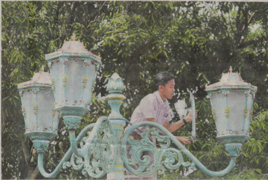
PERAWATAN LAMPU - Pekerja melakukan perawatan lampu kota di kawasan Alun-alun Kidul, Yogyakarta, Jumat (17/3). Perawatan dilakukan agar lampu tetap berfungsi sebagaimana mestinya.
