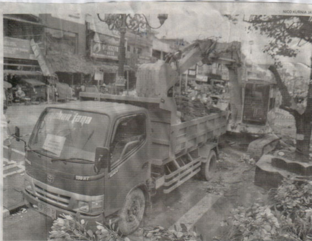
PENATAAN MALIOBORO TAHAP DUA Pekerja menyelesaikan penataan atau revitalisasi Malioboro tahap dua di depan Pasar Beringharjo, Yogyakarta, DIY, Rabu (15/3). Penataan tahap dua mengusung konsep street furniture . Namun pada tahap kedua akan ada penambahan asbak di sepanjang jalur pedestrian sebagai tempat membuang putung dan abu rokok.
