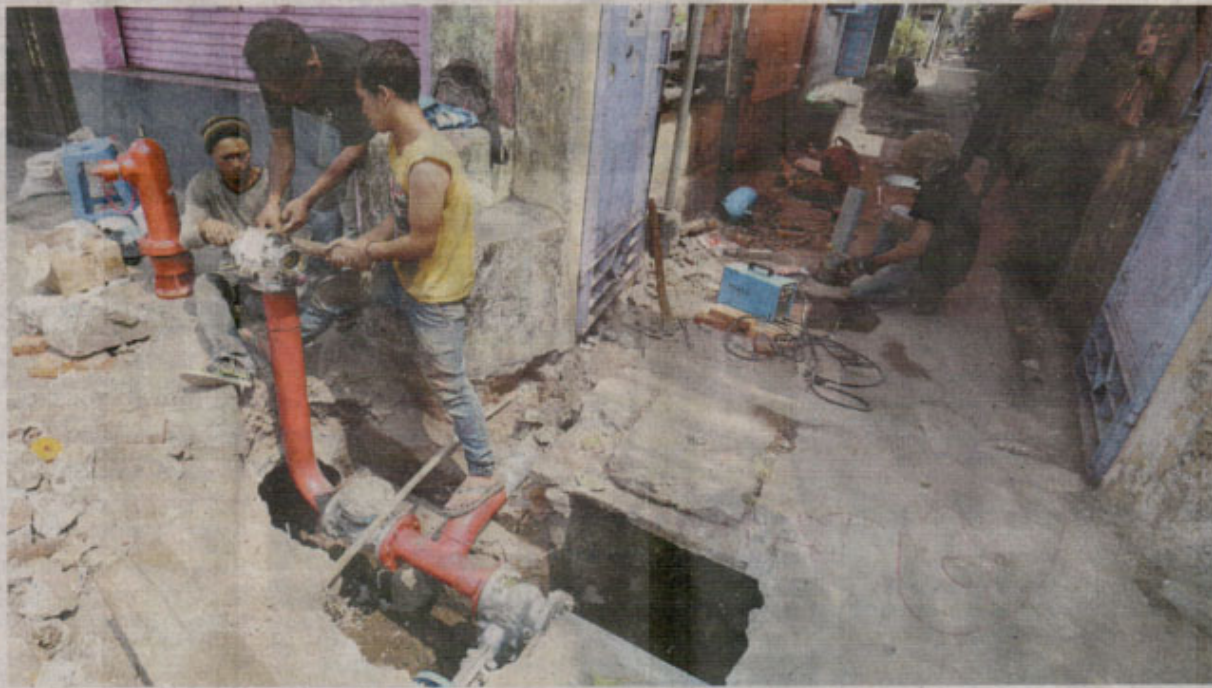
PASANG HIDRAN - Pekerja menyelesaikan pemasangan hidran di Jalan Kauman, Kota Yogyakarta, Kamis (5/11). Pemasangan hidran untuk memudahkan penanganan kebakaran yang terjadi di perkampungan padat penduduk.
