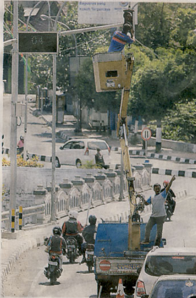
PERAWATAN APILL - Petugas melakukan perawatan alat pengatur lalu lintas di kawasan Kleringan, Kota Yogyakarta. Dishub akan menambah APILL panel surya dan ATCS.
