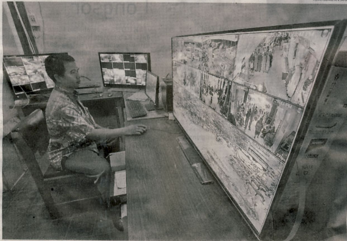
CCTV Pasar Tradisional Petugas Dinas Pengelolaan Pasar Beringharjo memantau keamanan pasar menggunakan kamera CCTV di Pasar Beringharjo, Yogyakarta, Selasa (20/1). Sebanyak 32 buah CCTV telah terpasang di Pasar Beringharjo untuk membantu petugas mengamankan pasar tradisional yang menjadi salah satu ikon wisata di Kota Yogyakarta tersebut.
