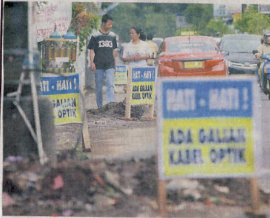
TRIBUN JOGJA/HENDRA KRISDIANTO KABEL OPTIK - Pengguna jalan melintas didekat galian kabel optik di kawasan Jalan Bausasran, Yogyakarta, Rabu (20/11).
