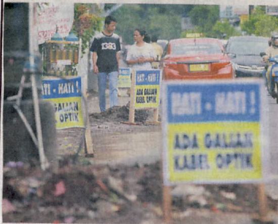
KABEL OPTIK - Pengguna jalan melintas didekat galian kabel optik di kawasan Jalan Bausasran, Yogyakarta, Rabu (20/11).
