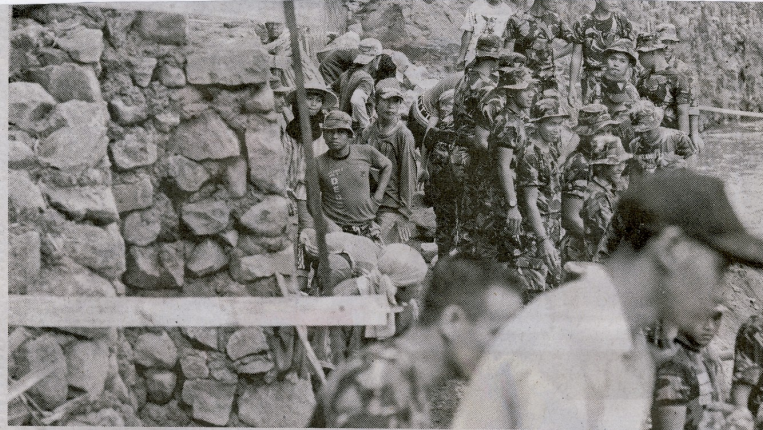
MEMBANGUN TALUD: Anggota TNI dari Kodim 0734/Yogyakarta bersama pekerja lepas saat membuat talud sepanjang 45 meter di Sungai Code di Kelurahan Terban, Kec. Gondokusuman, Jogja, Rabu (13/10). Kegiatan tersebut merupakan bagian dari melaksanakan TNI Manunggal Membangun Desa (TMMD) Reguler ke-85 Tahun 2010 yang berlangsung hingga 2 November 2010.
